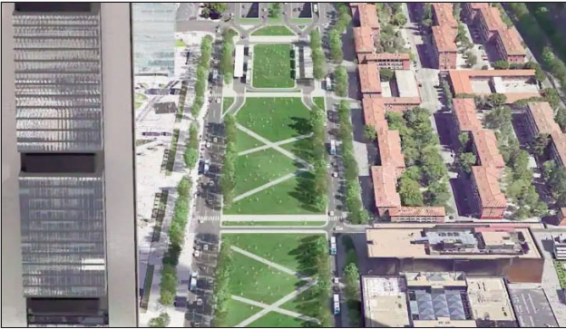
En la zona norte de la Castellana se creará un túnel liberando espacio para zonas verdes en a la altura de las Cuatro Torres
