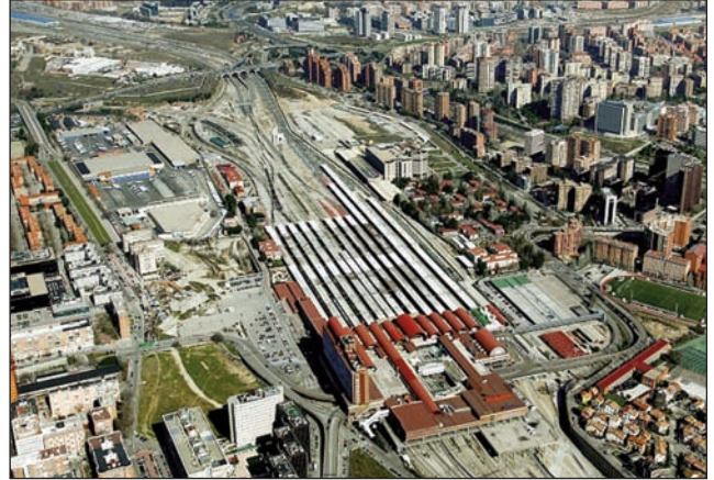
Vista aérea de la estación y la playa de vías en cuyo cubrimiento se trabaja
