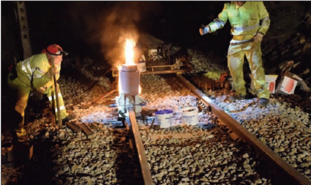
Inicio de la reacción en el crisol sobre la zona de soldadura entre carriles
