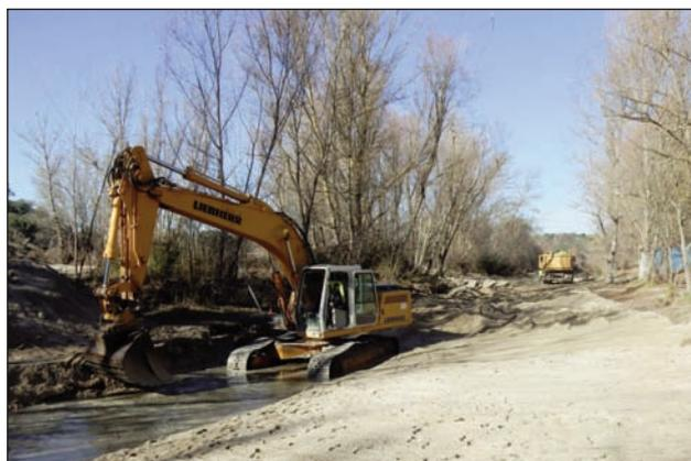
Extracción de sedimentos del brazo original del Manzanares en Somontes,/ Fuente: CHT. M<sup>º</sup> para la Transición Ecológica y el Reto Demográfico.
