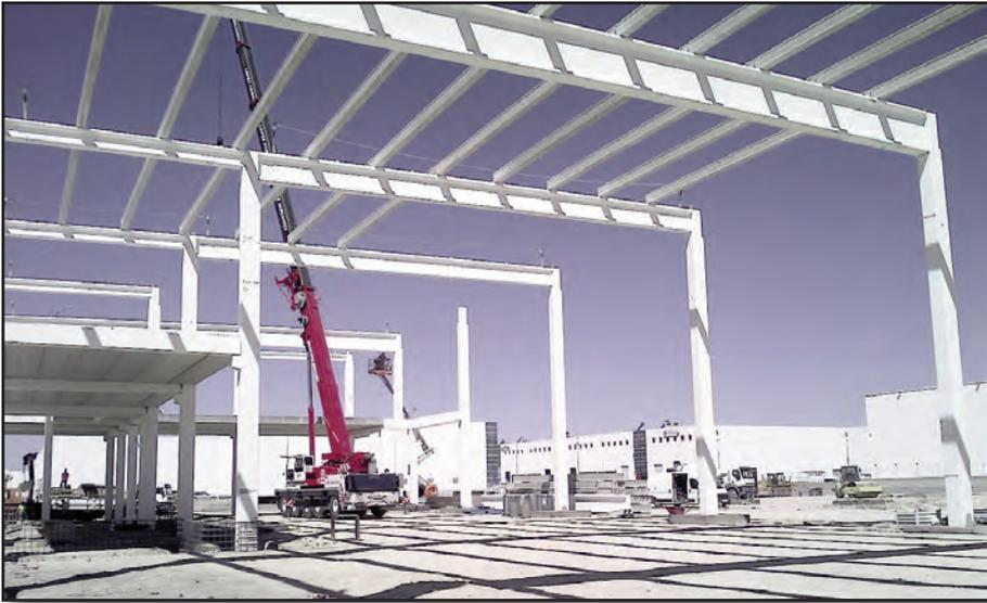
Figura 1. Estructura de Cubierta Ligera: Pilares, vigas principales y correas tubulares. Fase de montaje en el Edificio 2
