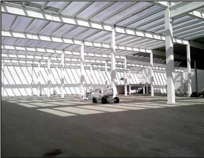
Figura 5. Estructura de Cubierta Ligera: Pilares, vigas principales y correas tubulares. Fase de montaje en Edificio 2
