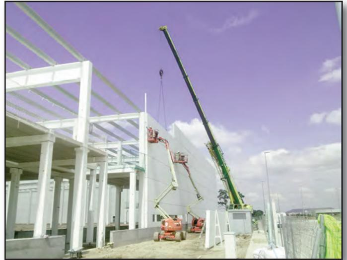
Figura 6. Estructura de Cubierta Ligera: Pilares, vigas principales y correas tubulares. Fase de montaje en Edificio 2
