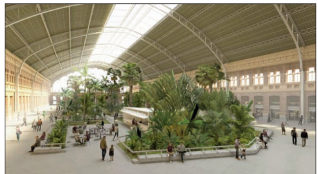
Acondicionamiento de la marquesina histórica
