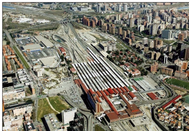
Vista aérea de la estación y la playa de vías en cuyo cubrimiento se trabaja
