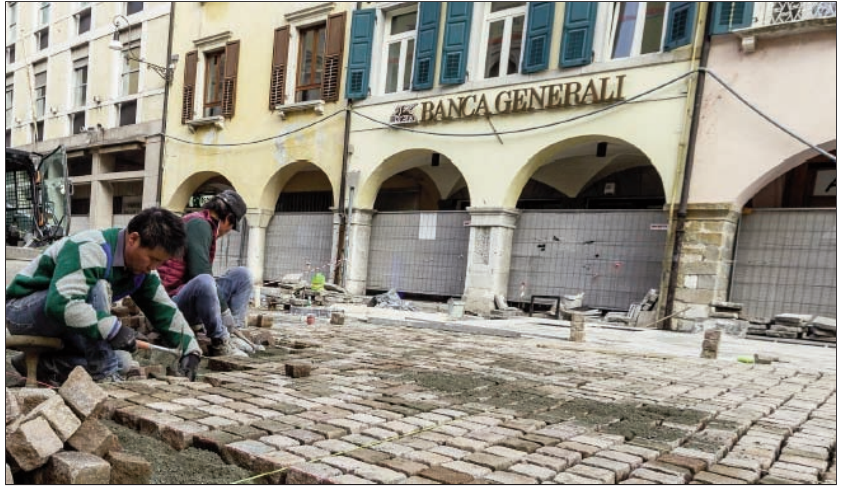
Ejemplo de pavimentación urbana sostenible con piedra (adoquinado)
